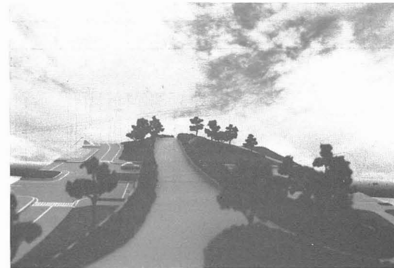
■ 歩行者が橋を意識させないようになめらかな曲線でアプローチをすりつける
