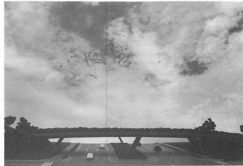
■ 桁自体をスレンダーにしてあまりごつい感じをださない
