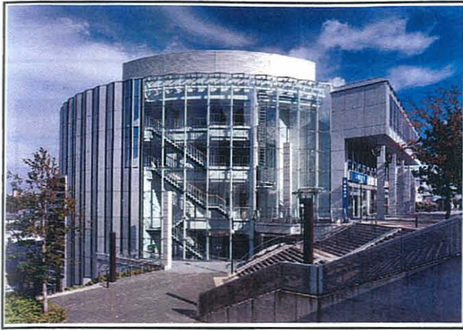
都筑区総合庁舎
