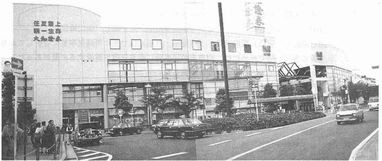
ペアビル古川橋
