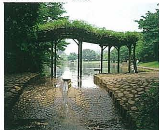
緑道へのせせらぎ放水堰
