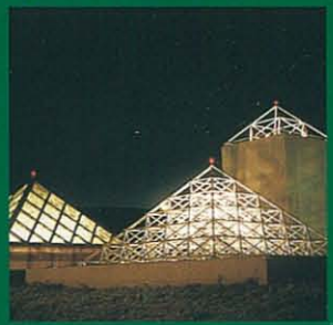
センター北駅 給気塔・排気塔
