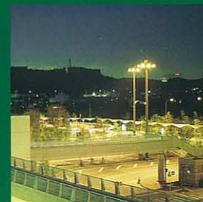
センター南駅前広場 照明塔
