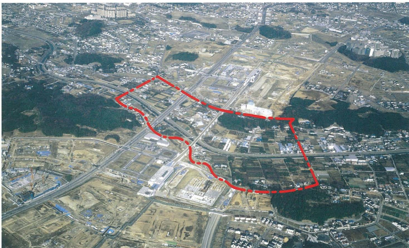
現況航空写真(平成5年12月撮影)
