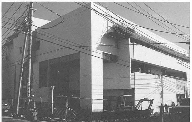
▲建設が進む緑区図書館・老人福祉センター
