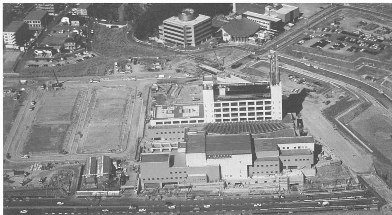
都筑区総合庁舎
