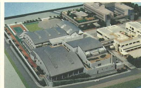
障害者スポーツ文化センター
