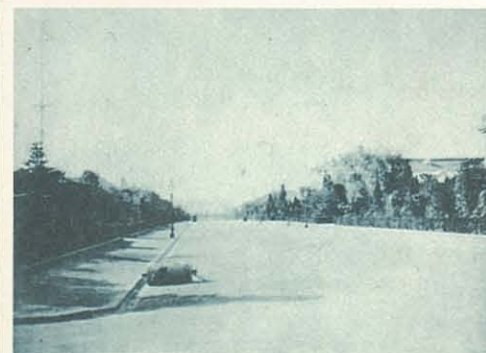
日本大通り(県庁より横浜公園を望む) 明治20年頃
