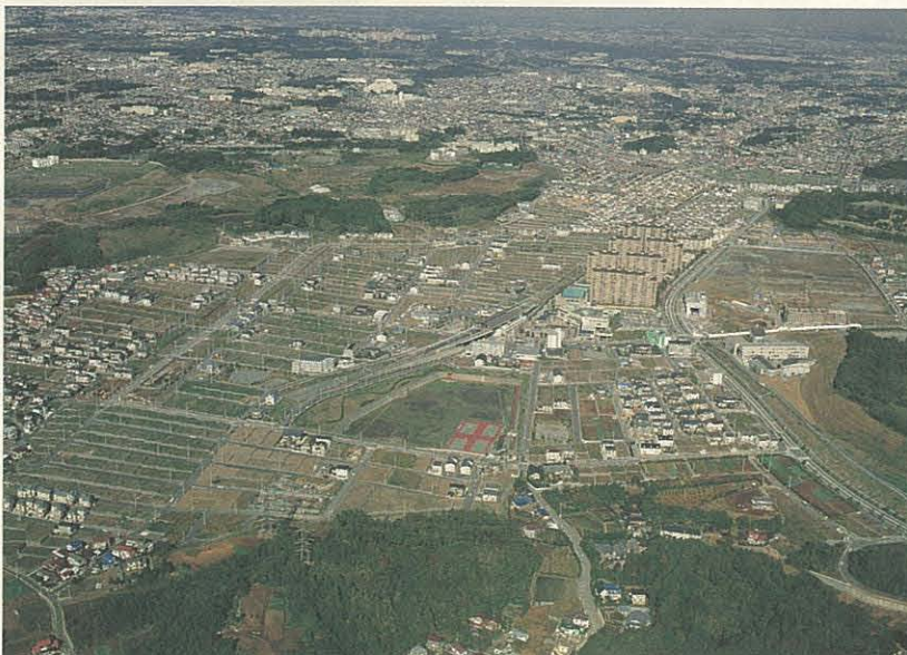
土地区画整理事業(中川第一地区)
