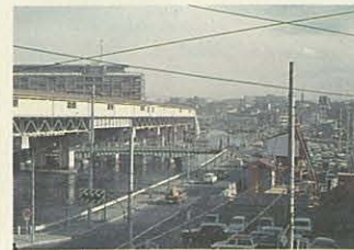
関内駅・市庁舎周辺 昭和40年頃
