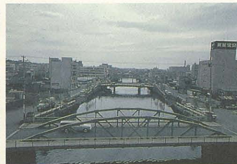
大通り公園(整備前)
