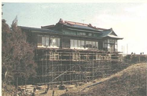
大規模な曳家工事
