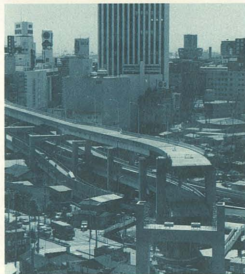
建設中の高速道路三ツ沢線 横浜駅付近 昭和48年頃
