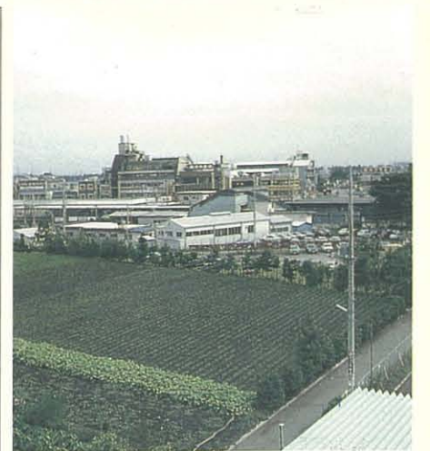
湘谷駅北口全景
