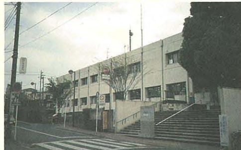
瀬谷区総合庁舎
