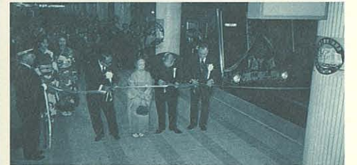
高速鉄道建設(市営地下鉄開通) 昭和47年
