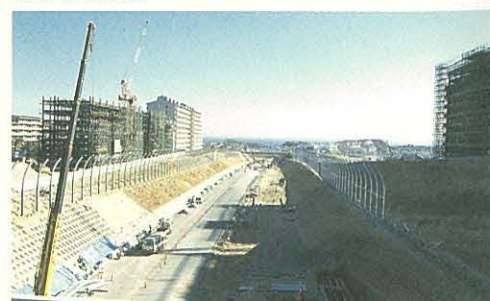
工事のすすむ湾岸線
