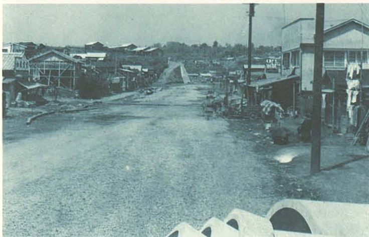
戦災復興区画整理事業の施行状況 国道1号バイパス(反町地区)
