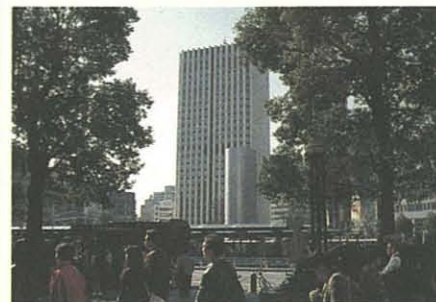
特定街区ビル(天理ビル)
