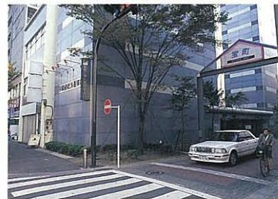
平塚MNビルパーキング／隣接する事務所ビルと色彩を揃えて統一感を出している例です。緑化も積極的に行っています。
