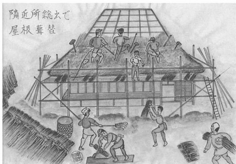
屋根葺きは屋根職人の指図のもとに、隣近所総出で行われた。
