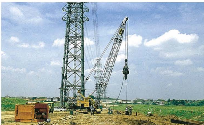
道路整備(新横浜・元石川線)
