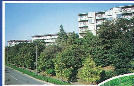
幹線道路沿いの保存緑地、住棟との間に緩衝緑地帯としての機能をもつ。
