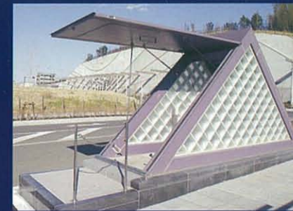
【出入口】 カード方式の電気錠により地上扉が閉鎖し、不法侵入を防いだ安全管理を行っています。 The electric card key maintains security by controlling access.
