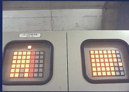
【区域制御盤】 共同溝の状態が一目でわかるようになり、異常がある場合は赤ランプが点灯します。 The red light comes on in case of emergency.
