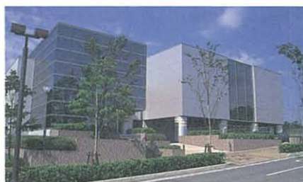
地域冷暖房プラント
