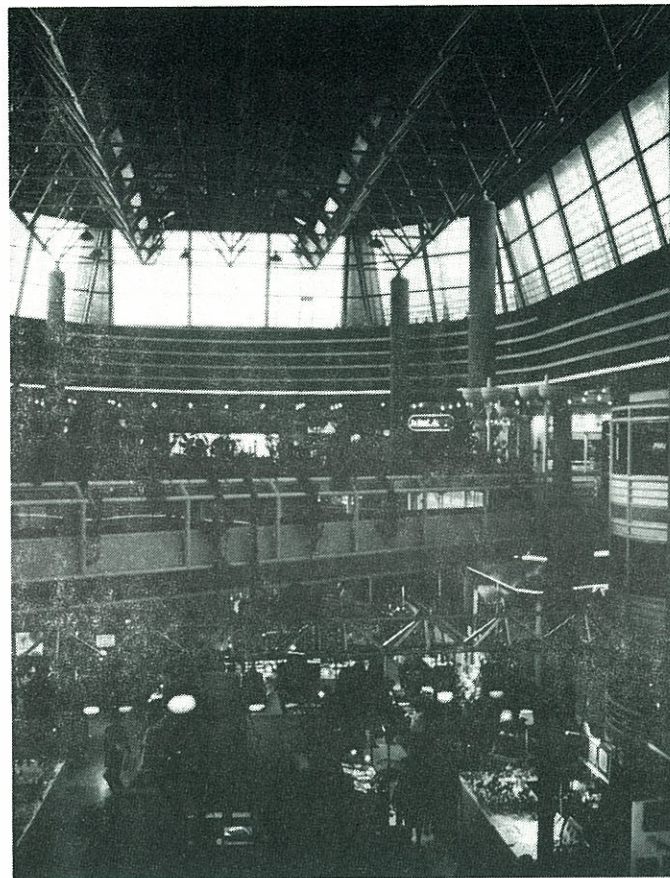
ロレ・カトル・タン・ショッピングセンターの内部
