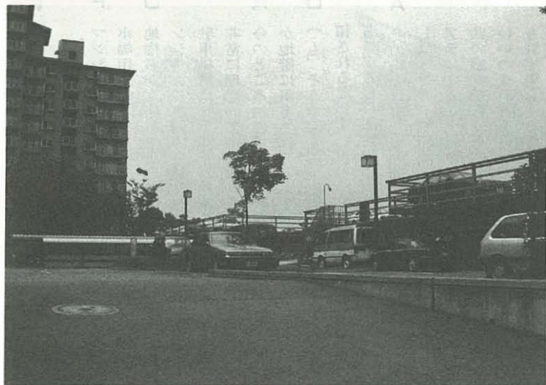
7 エステスクエアでは2層式駐車場を設置した
