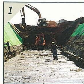
掘削工事 道路建設に先行して共同溝整備スペースを掘削します。
