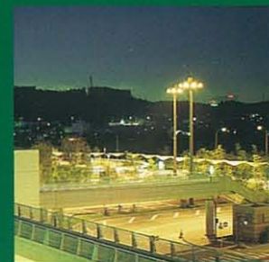
センター南駅前広場 照明塔
