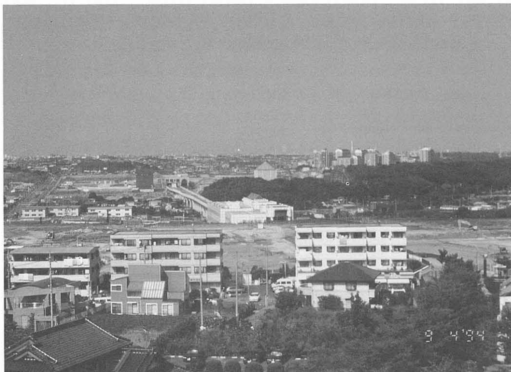
建設がすすむニュータウン地区
