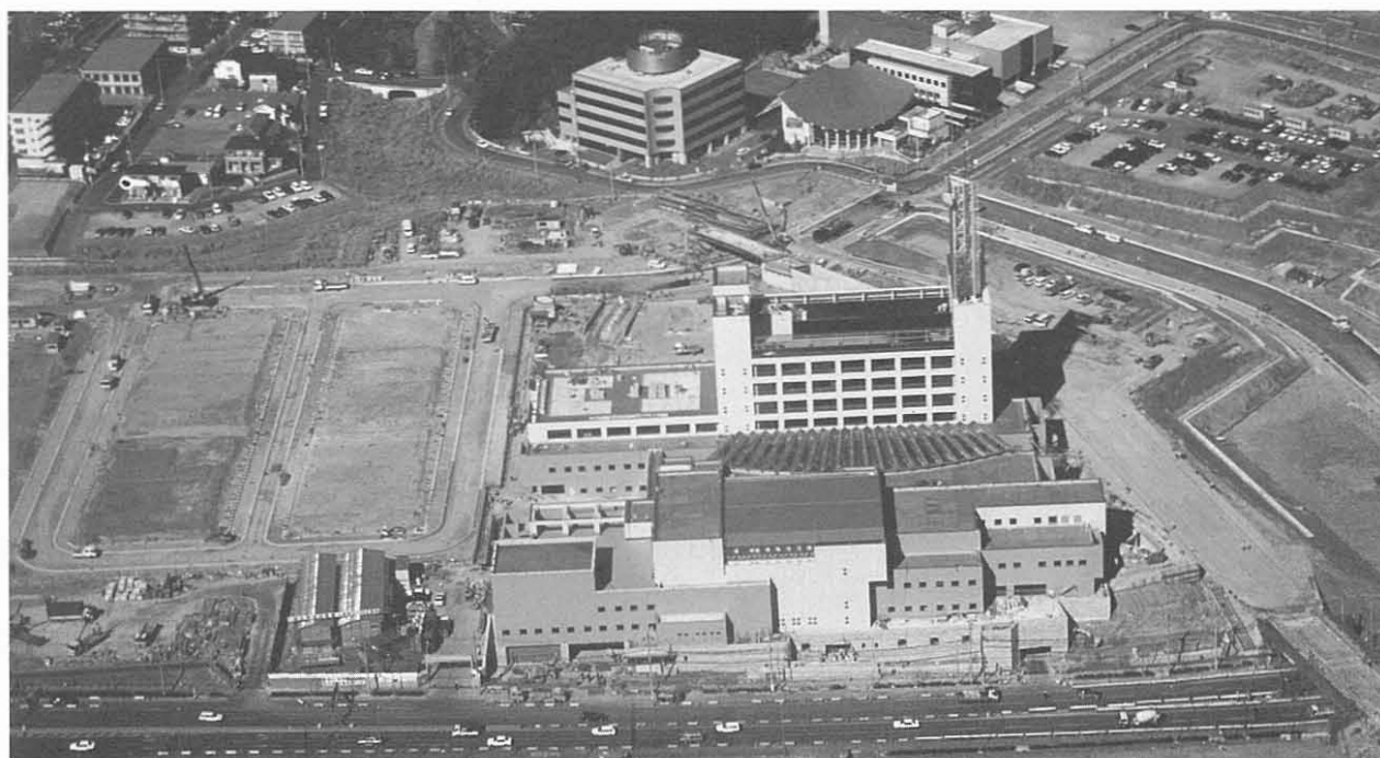
都筑区総合庁舎
