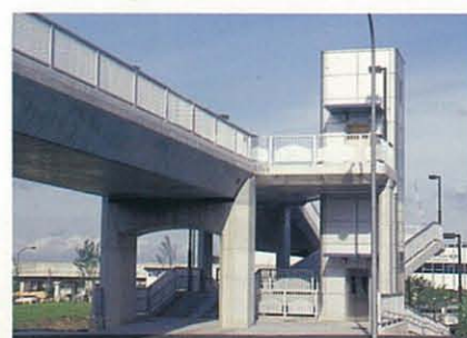
[みらい歩道橋] 前後両ドアになっており、車椅子のかたでも楽に移動ができるエレベーター付きの橋です。 Mirai (future) Crossover: It has an elevator with doors on both sides in order to make ambulation on a wheelchair easy.
