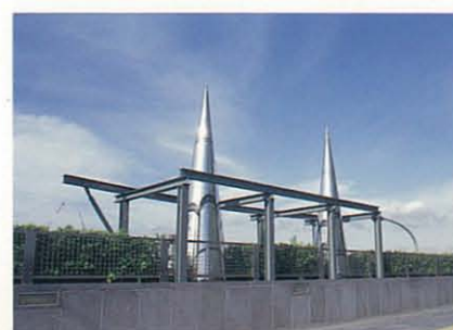
[都筑ふるさと歩道橋] 橋の中央にはユニークな金属製オブジェがあり、センター南地区のシンボル橋です。 Tsuzuki Furusato (hometown) Crossover: There is a unique metal object of art at the center. This is the symbol bridge of the Center South Area.
