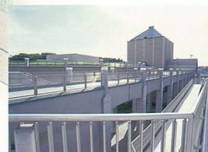
[道跡公園歩道橋] 横浜市歴史博物館との一体的なデザインになっています。 Iseki (Monument) Park Crossover: Design is unified with that of the Yokohama History Museum.
