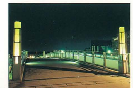
[ほのか歩道橋] シンボル広場に接続しており、夜間は親柱が光ります。 Honoka (delicately lighted) Crossover: It adjoins the Symbol Plaza. Newels lights at night.
