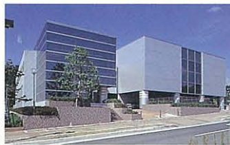
地域冷暖房 プラント
