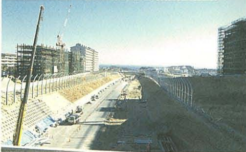
工事のすすむ高速湾岸線
