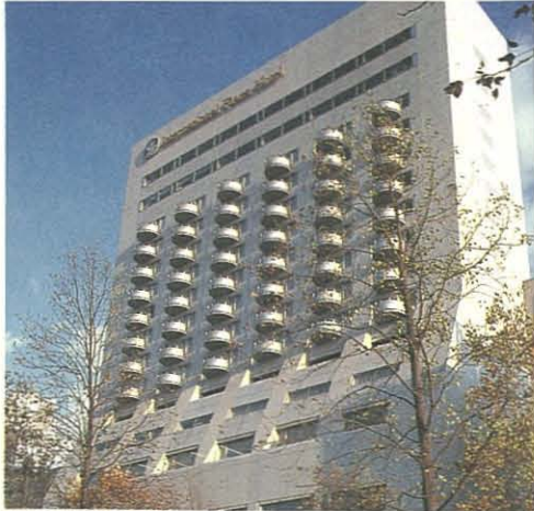
大通り公園周辺の街並み(建物)
