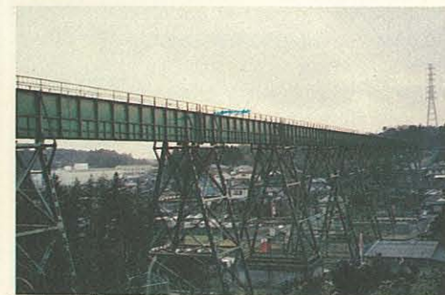
大貫谷戸水路橋
