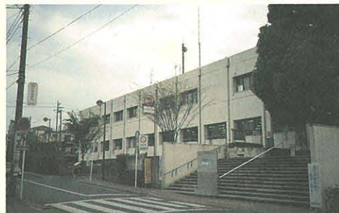
瀬谷区総合庁舎
