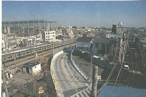
真光寺長津田線と鉄道の立体交差
