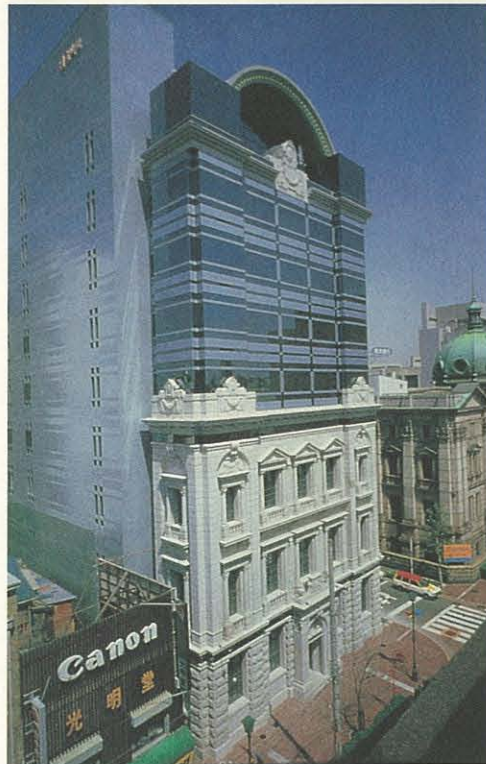
日本火災横浜ビル
