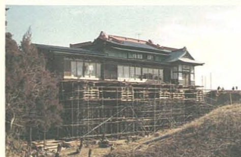
大規模な曳家工事
