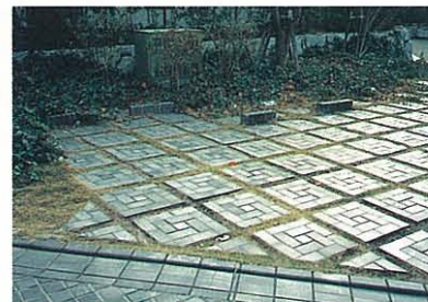
駐車場の路面も、緑化するなどの工夫によって親しみやすい場所づくりが可能です。
