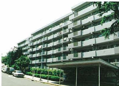
住居ベランダの布団や洗濯物は丸見えにならないように手すり等のデザインを行いましょう。
