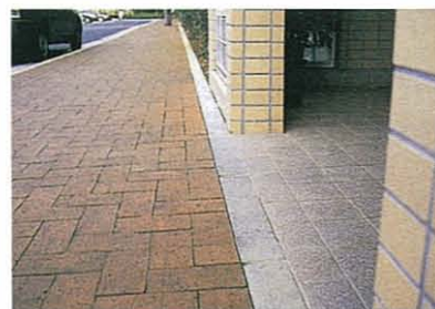
歩道から建物入口部分は小さな段差が生じやすい所です。注意して施工しましょう。 〈写真：「日経コンストラクション」1991年8月9日号より転載(左とも)〉
