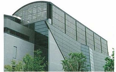
カバーを建物と一体的に作った例です。パンチングメタルで屋根の形に覆っています。
