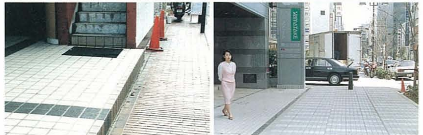
折角の壁面後退も、看板、自販機や設備の分電盤等で後退部分が分断され連続性がなくなっています。段差もなくしましょう。
