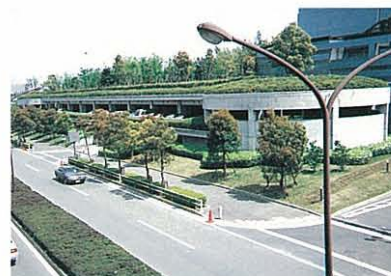
多摩センター駐車場/道路沿いを緑化して、車両が丸見えにならないように工夫しています。
