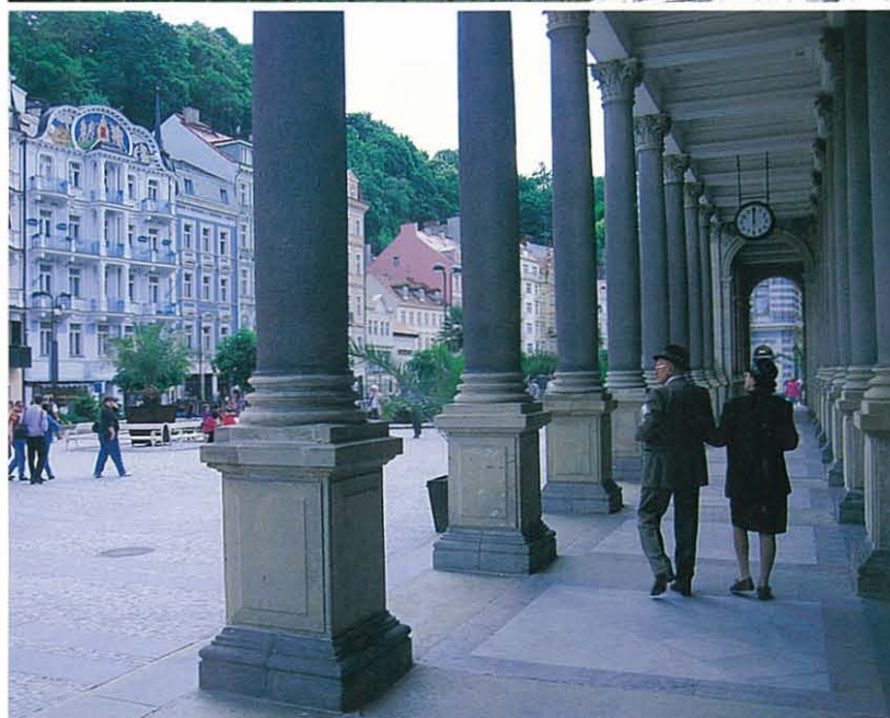
回廊は大きなシンボル広場と建物を人のスケールで結び付ける役割を持ちます。
