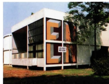
Pavillon de l'Esprit Nouveau 1925, by Le Corbusier Paris, France
