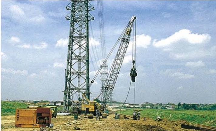
道路整備(新横浜・元石川線)
