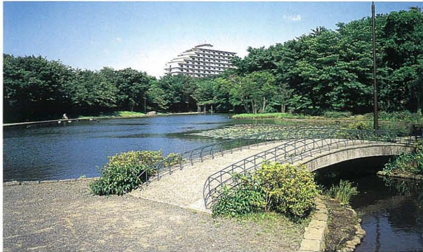
せせらぎ公園とライフケア横浜港北
