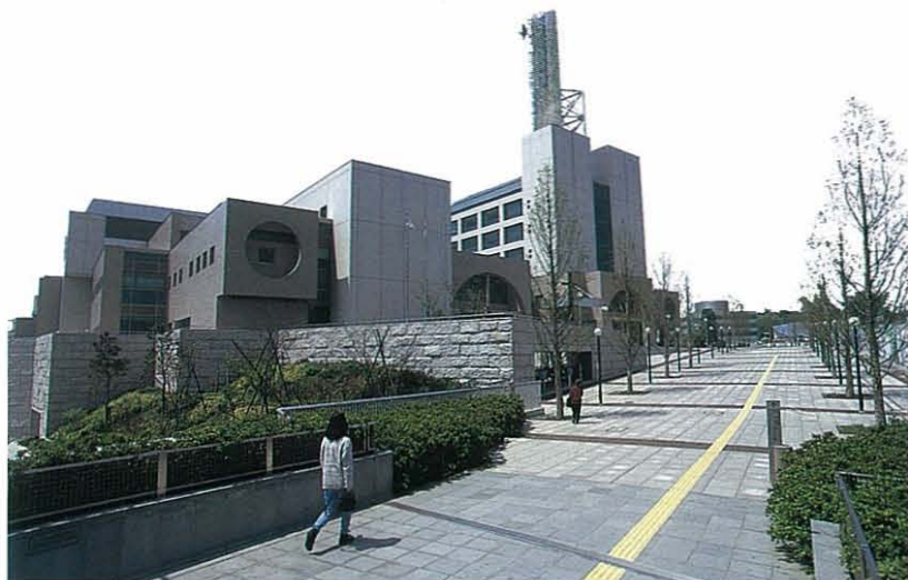
都筑区総合庁舎
