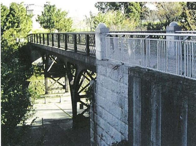
歴史景域の橋（若水橋）
