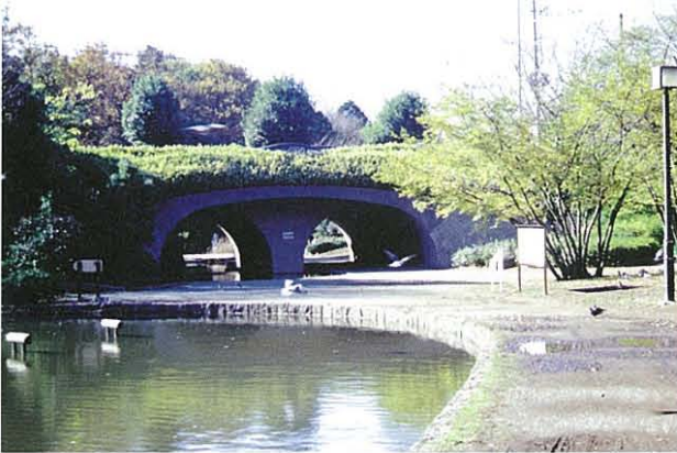
中景域の橋（せせらぎ橋）
