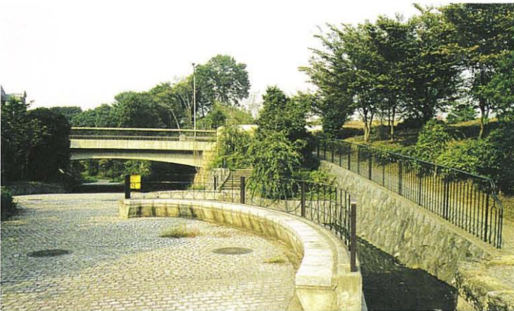
近景域の橋（茅ヶ崎貝塚橋）
