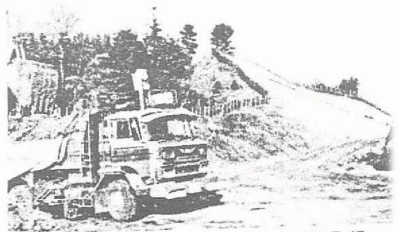
日吉元石川線工事現場 (牛久保町付近：公団との同時施工箇所)
