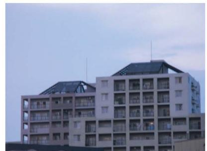
屋上の設備機器を建物デザインと合わせた水平ルーバーで遮蔽し、寄せ棟屋根のように修景化している。
