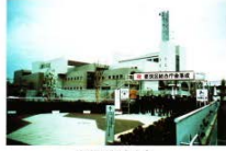
都筑区総合庁舎
