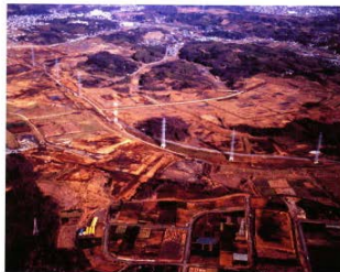
昭和54年頃 造成工事の様相(新横浜元石川線と中山北山田線との交差点付近)
