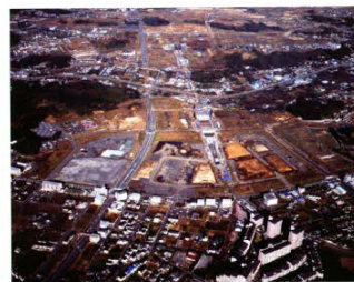
平成2年頃地下鉄3号線工事(タウンセンター)
