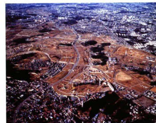
平成3年頃の造成工事の様子(南山田、北山田付近)
