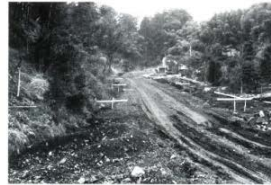
仮設道路の建設
