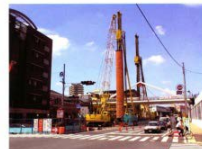
4号線工事(北山田駅)
