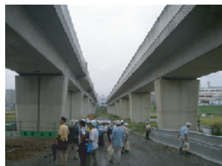
港北ニュータウン14号線（南北歩行者専用道路）の現地調査
