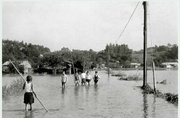
写真：昭和 42 年・台風による鶴見川の氾濫の様子
