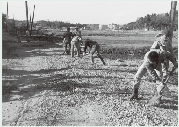
写真：昭和 40 年代・道路普請の様子
