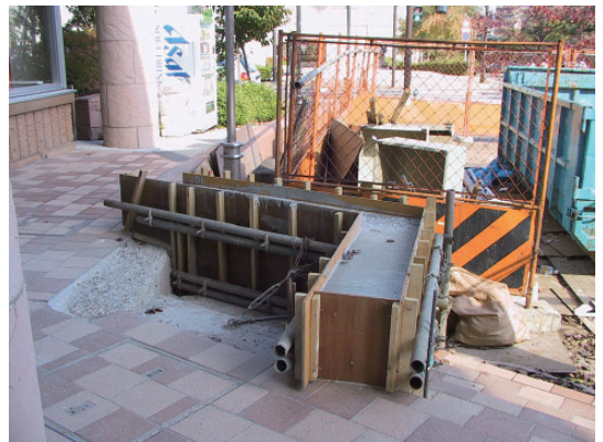
まちづくり館正面 手すり工事
