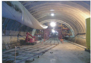
山岳トンネル坑内 (日吉本町付近)
